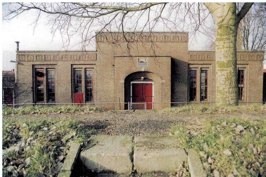
De achterkant (de spuijzide) van het gemaal, gezien vanaf de kanaaldijk.
